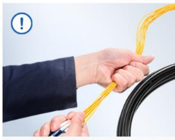
Controlar la tensión aplicada a los breakouts
